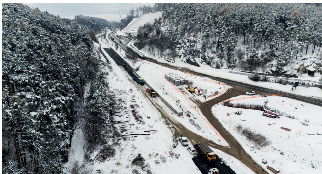
Die Arbeiten laufen auf Hochtouren.
