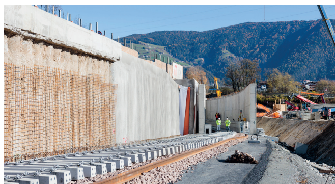
Zwei neue Zughaltestellen entstehen in Vahrn und Natz-Schabs.
