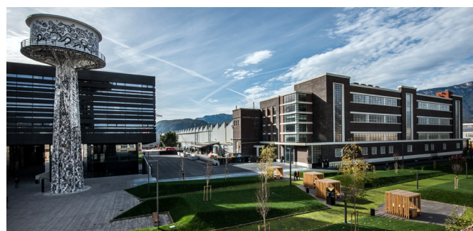
Der NOI Techpark in Bozen
