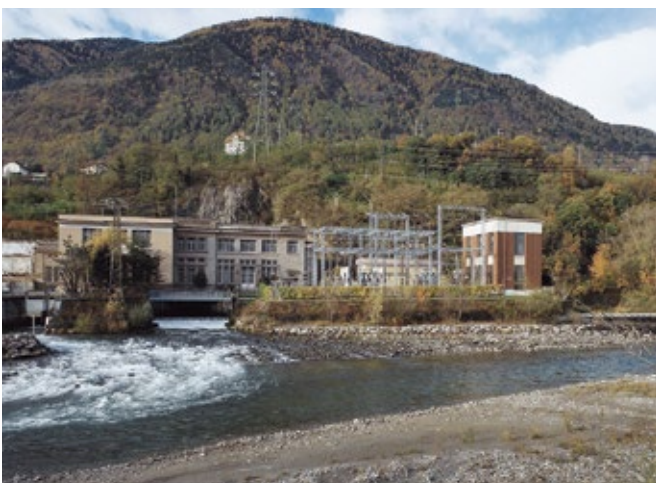
Das Kraftwerk in Marling
