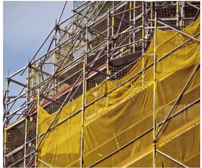
Für die Sanierung der Fassaden gab es die Möglichkeit für einen Steuerabzug
