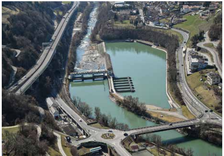
Die Flusssperre und der Speicher in Kollmann bei Barbian werden zur Energieerzeugung genutzt, ebenso wie der Stausee Vernagt in Schnals, der auf dem Titelbild zu sehen ist.
