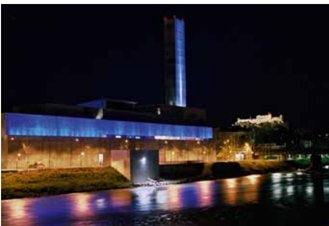
Der Turm des Heizkraftwerks in Salzburg ist in blaues, fast samtiges Licht getaucht und in der Dunkelheit kilometerweit zu sehen. Foto: Scheinast
