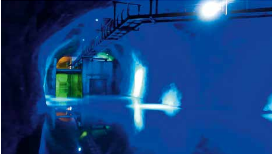
Das Wasserkraftwerk St. Anton ist eines der größten unterirdischen Wasserkraftwerke Italiens und kann besichtigt werden. Entlang der fast 1.000 Meter tiefen Tunnelschächte gelangt man vorbei an Staubecken, Leitungen und Turbinen ins Berginnere zu einer Aussichtsplattform. Foto: Sushi Peng
