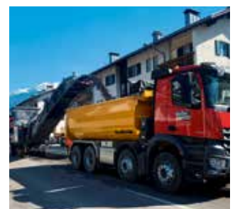
2022 investiert das Land Südtirol 38,5 Millionen Euro in die Instandhaltung der Straßen. Foto: LPA
